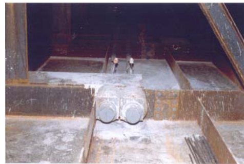
Figura 5.23 – Ancoraggi cavi iniettati
