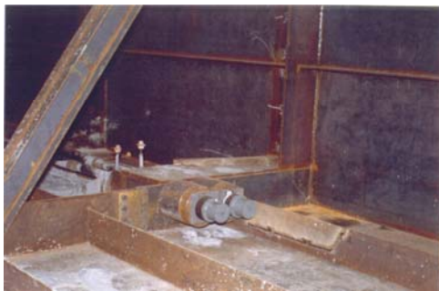
Figura 5.23 – Ancoraggi cavi iniettati
