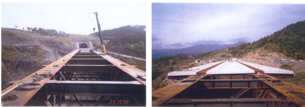
Figura 5.21 – Varo trave a cassone e posa solette in c.a.
