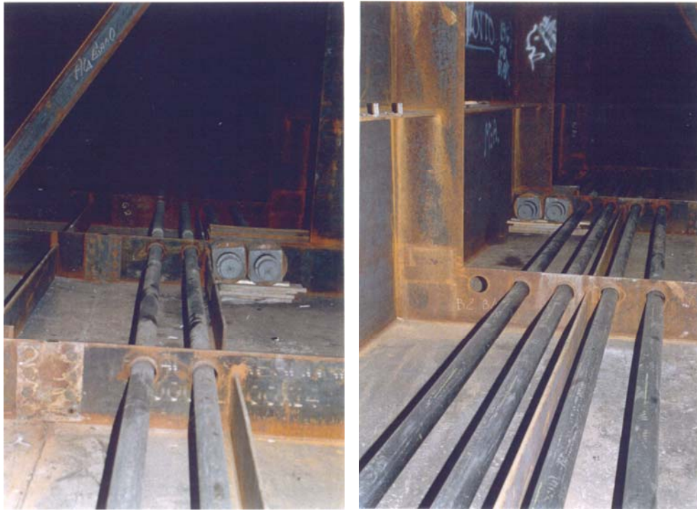
Figura 5.24 – Variazione numero cavi lungo la trave
