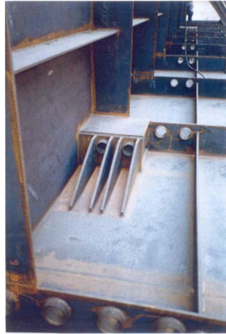
Figura 5.22 – Fori passaggio cavi e particolare ancoraggi
