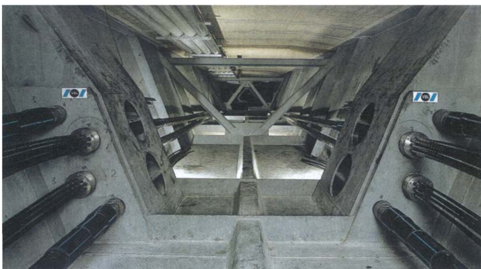
Figura 5.14 – Vista cassone e cavi di precompressione
